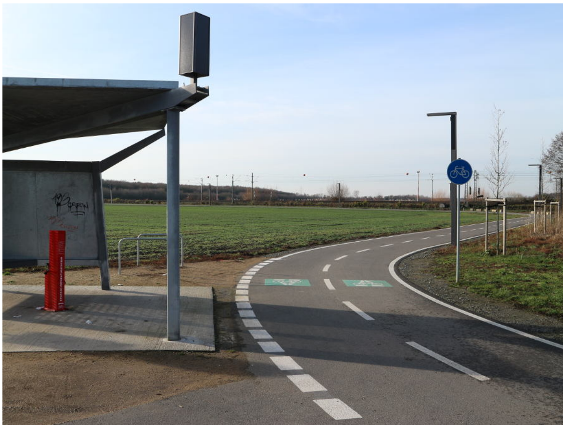
Abbildung 5.2 Getreut dem Motto „Wer Radwege sät wird Radverkehr ernten“ sticht der bereits fertige gut ausgebaute Radschnellverbindung in der Heatmap hervor. Hier ein Blick auf die gut ausgebauten bereits fertigen Streckenabschnitt südlich Egelsbach. Bild: Dirk Schmidt 01-2019).
