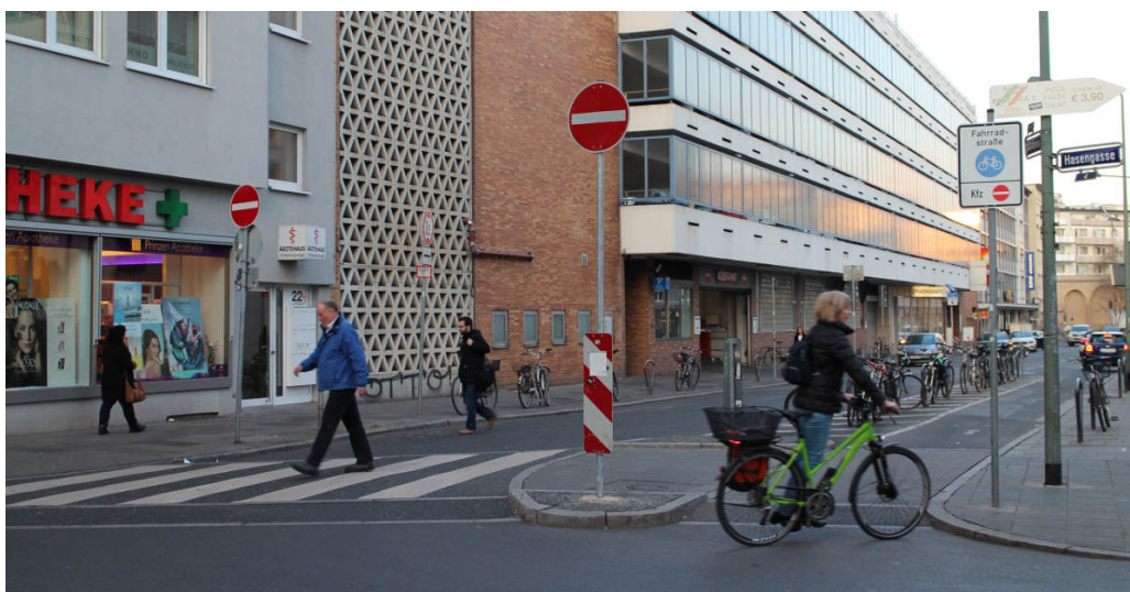
Abbildung 3.94 Warum der Zebrastreifen nicht auch über die Radfahrbahn geführt wurde ist umklar. Im Sinne einer eindeutigen, sicheren Verkehrsregelung zugunsten des Fußverkehrs wäre dies sinnvoll. Geo 50.11344 8.68399. Bild: Dirk Schmidt 04-2016.
