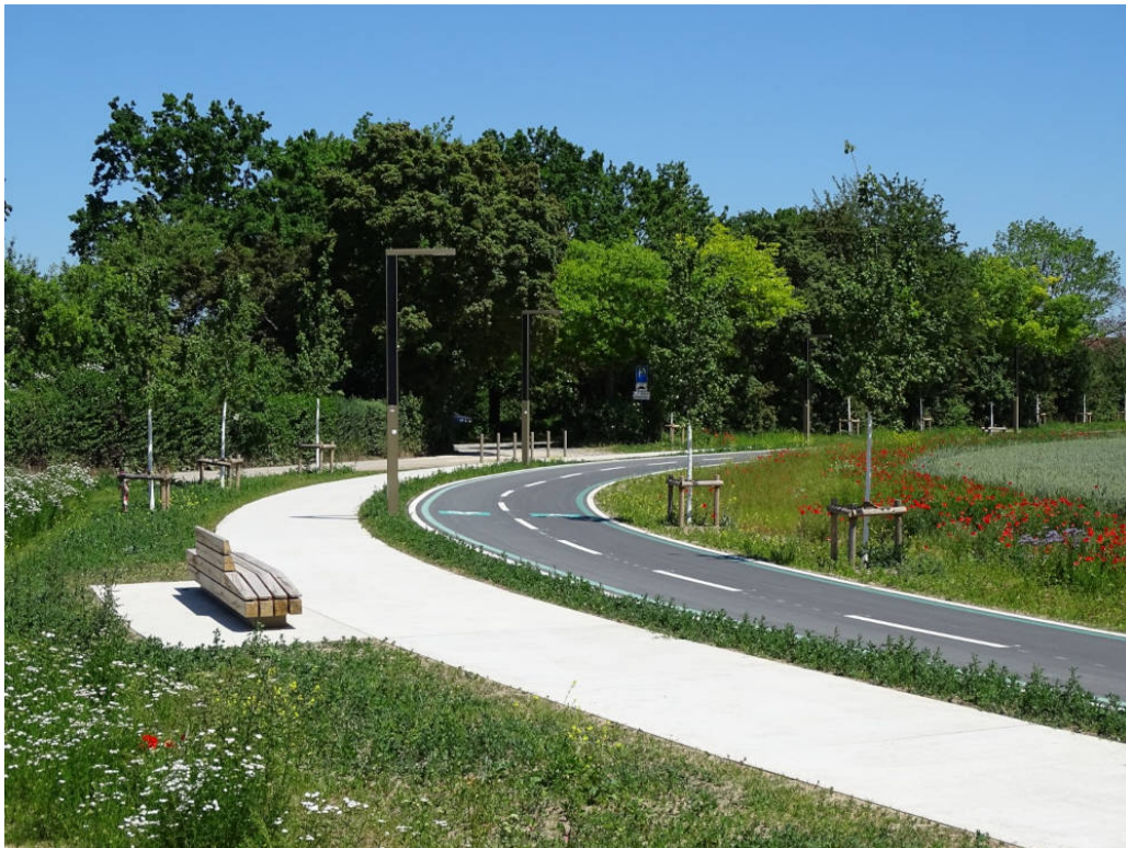
Abbildung 3.23 Blick auf den ersten Bauabschnitt des RS 15, der einmal Mannheim mit Weinheim verbinden soll. Das Projekt im Buch im Kapitel 4 „Fahrradachsen, Radschnellverbindungen und Radpendlernetze“ näher beschreiben (Bild: Swen Schneider 06-2023).
