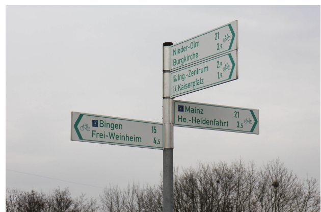
Abbildung 3.99 Hier wurde korrekt montiert: die abzweigenden Wegweiser hängen oben. (Bild: Dirk Schmidt 04-2016).
