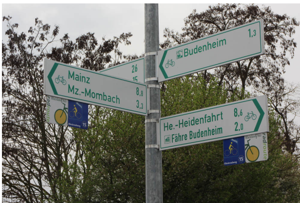
Abbildung 3.98 T-Knoten falsch beschildert: der mittlere Pfeilwegweiser verdeckt die weitere Beschilderung (Bild: Dirk Schmidt 04-2016).
