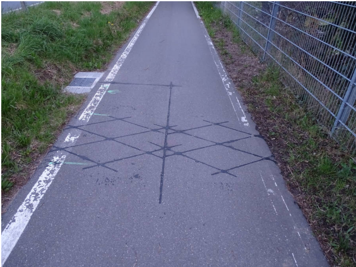
Abbildung 5.1 Blick auf die Zählstelle 334 bei Bensheim. Die Technik ist recht unscheinbar. Unter den schwarzen Linien finden sich die Induktionsschleifen (wurde mit Bitumen abgedichtet). Links oben am Wegrand findet sich der Technikkasten.
