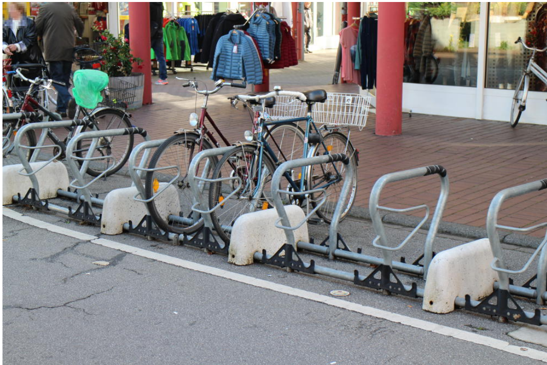
Abbildung 3.27 Fahrradparken - Lorsch Römerstraße: Dieser Ständer erfüllt im Prinzip alle oben gelisteten Anforderungen. Auf eine unergonomische Hoch-Tief-Einstellung wurde an diesem Standort hier in Lorsch richtigerweise verzichtet. Leider finden sich deutschlandweit enge, unergonomische Hoch-Tief-Einstellungen öfter auch noch an vielen Standorten, an denen eine hohe Parkfluktuation herrscht (Kurzzeit-Radparken). Dieses Modell vom Bild oben mit „Radfixierung“ nach allen Seiten ist auch bei den ADFC-geprüften Ständern zu finden. Mit den Betonelementen als Teil der Halterung ist der Ständer zudem für Veranstaltungen usw. einfach demontierbar. eingesehen werden. Geo: 49.65280 8.56748 Bild: Dirk Schmidt 05-2007
