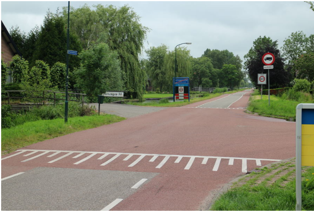
Abbildung 7.14 Ortsausgang der Straßensiedlung Portengensebrug; vorne Fahrbahnanhebung mit Rechts-vor-Links-Regelung. Bild: Dirk Schmidt 06-2015
