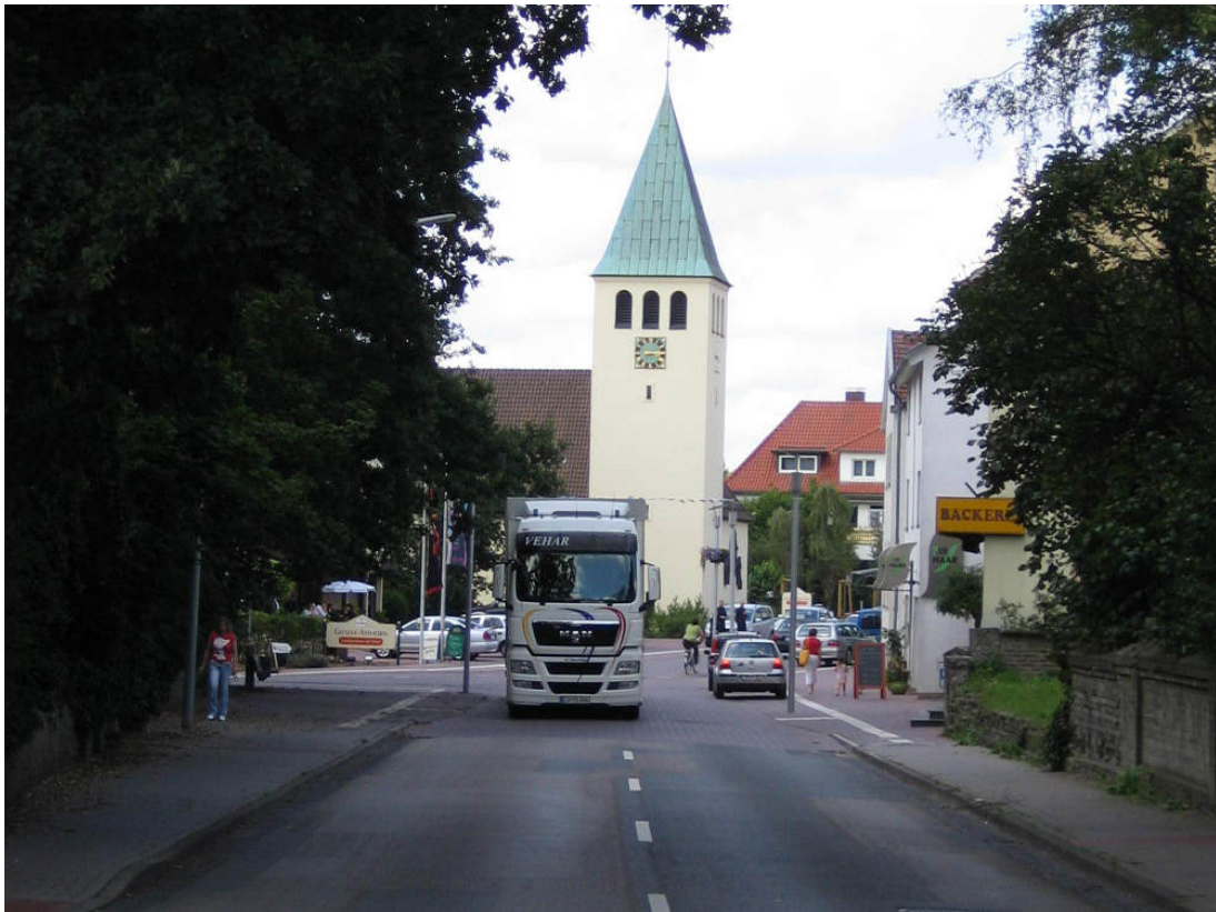
Abbildung 7.8 Blick vom bisherigen Querschnitt in den Shared Space Bereich. Da der Bordstein als klassische takile Trennung zur Fahrbahn weg fiel, kam ein taktilles Leitsystem im gesamten verlauf der Straßen zur Anwendung. Bild: Swen Schneider 08-2008.
