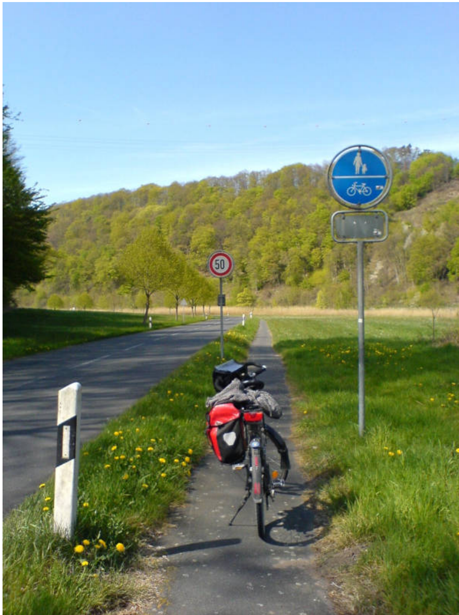
Abbildung 3.61 älterer viel zu schmaler Zweirichtungsradweg außerorts. Die Strecke dürfte positiv geschätzt maximal 1,2 m bis 1,3 m breit sein. Die Benutzungspflicht mit Zeichen 240 ist bei dieser Breite eigentlich nicht mehr zulässig. Das Grenzmaß beträgt hier nach StVO-VWV für Zeichen 240 gemeinsamer Geh- und Radweg außerorts 2 m. Ferner kommt hier hinzu das es sich hier um eine ruhigere Landstraße handelt. Radsportler sind hier in jedem Fall besser auf der Straße aufgehoben. Bild: Dirk Schmidt 2007
