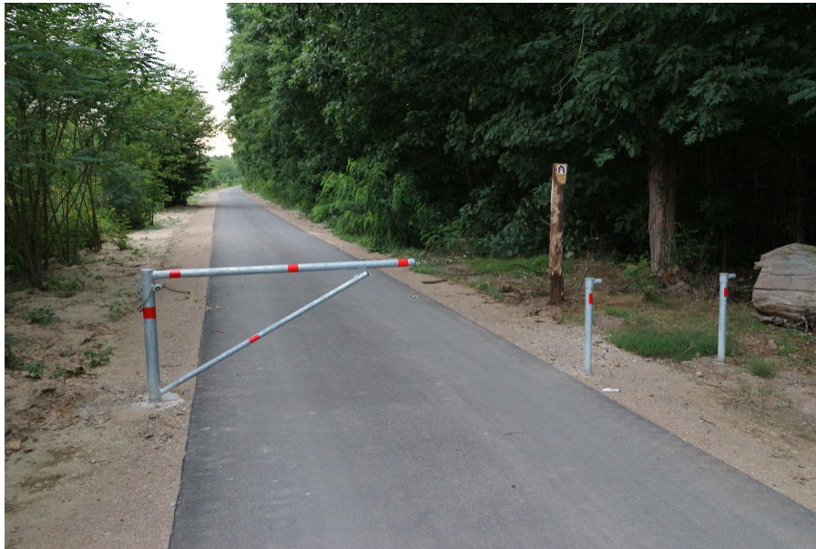
Abbildung 3.57 Südhessisches Ried: Graue Halbschranke auf dem neu ausgebauten hessischen Radfernweg R9 zwischen Lorsch und Bürstadt: Diese Halbschranke ist zwar gut durchfahrbar, aber nur mit wenigen Reflektoren ausgestattet. Da die Schranke außerorts in einer unbeleuchteten Örtlichkeit steht, sollte bei den Reflektoren unbedingt noch nachgerüstet werden. Bodenmarkierungen wären zusätzlich wichtig. Bild: Dirk Schmidt Sommer 2017
