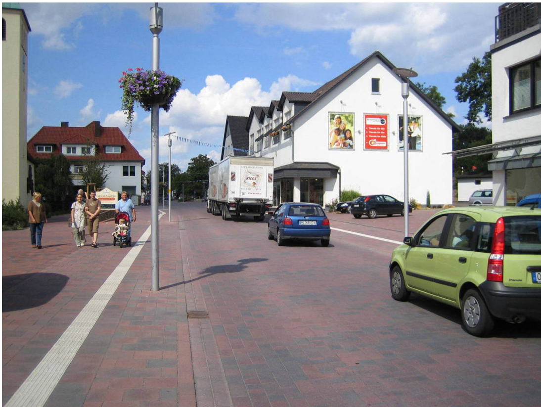
Abbildung 7.9 Durch die Entwässerung und das taktille Leitsystem besitzt die Verkehrsfläche real durchaus eine Gliederung in "Fahrbahn" und "Fußgängerbereich". Der Bereich zwischen Leitsystem und Entwässerung erscheint so etwas als "Parkstreifen". Bild: Swen Schneider 08-2008.
