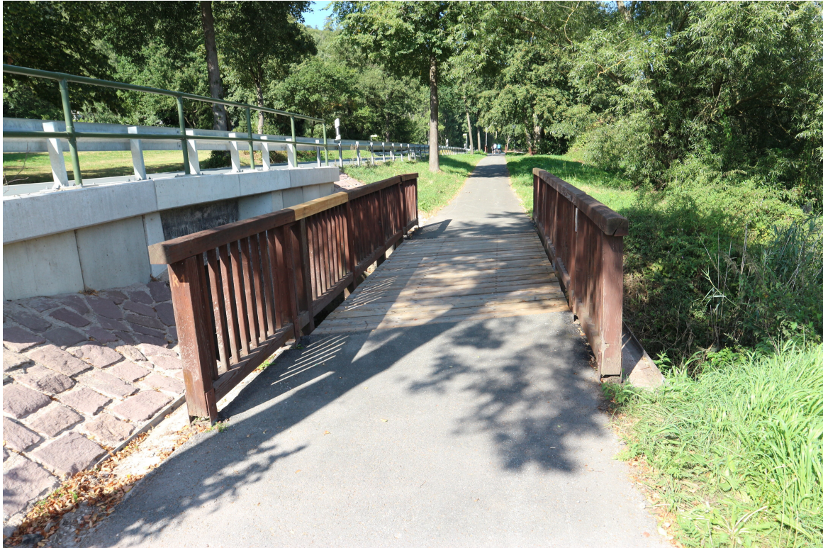
Abbildung 3.104 gefährliche Geländerstöße eines braun „getarnten“ Brückengeländers direkt am Fahrbahnrand (außerorts auf unbeleuchteter Strecke). Bild: Dirk Schmidt 2019.
