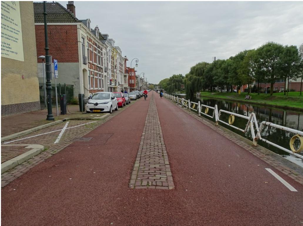
**Abbildung 10.18** Fahrradstraße in Utrecht mit Mittelpflasterung. Bild: Swen Schneider 10-2019
