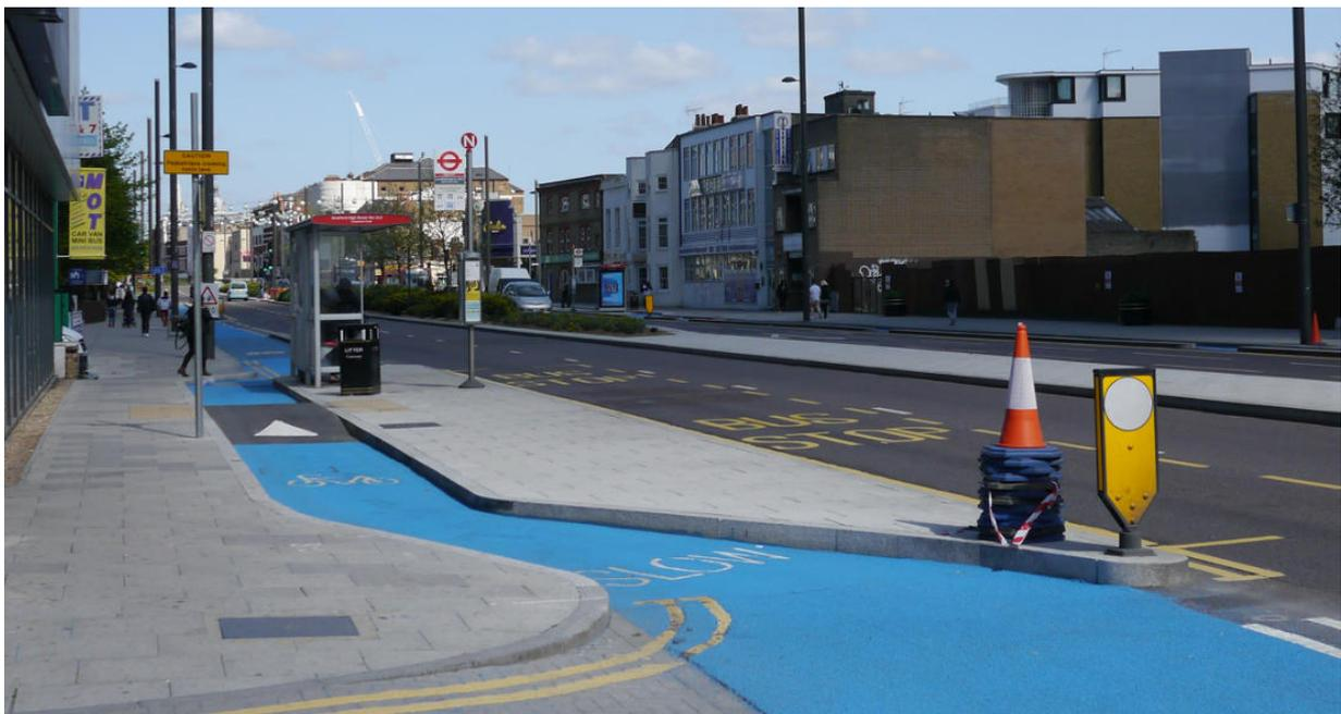
**Abbildung 11.19** Haltestellenumfahrung in London. Bild mit Dank an: Roald Oestreich 04-2014
