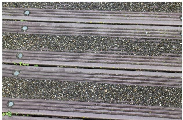
**Abbildung 4.7** Die Kunststoffbohlen mit mittigem Splitstreifen im Detail (Bild: Dirk Schmidt 09-2014).
