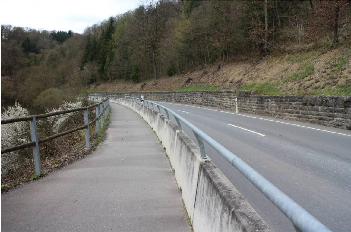
**Abbildung 7.7** Jagst-Radweg bei Berlichingen entlang der L1025: Aufgrund des durch den Prallhangs beengten Raums wurde der Zweirichtungsradweg mit einer platzsparenden und zugleich verkehrssicheren Betonbarriere abgeteilt. Bild: Dirk Schmidt 04-2016 Geo 49.33107 9.48637
