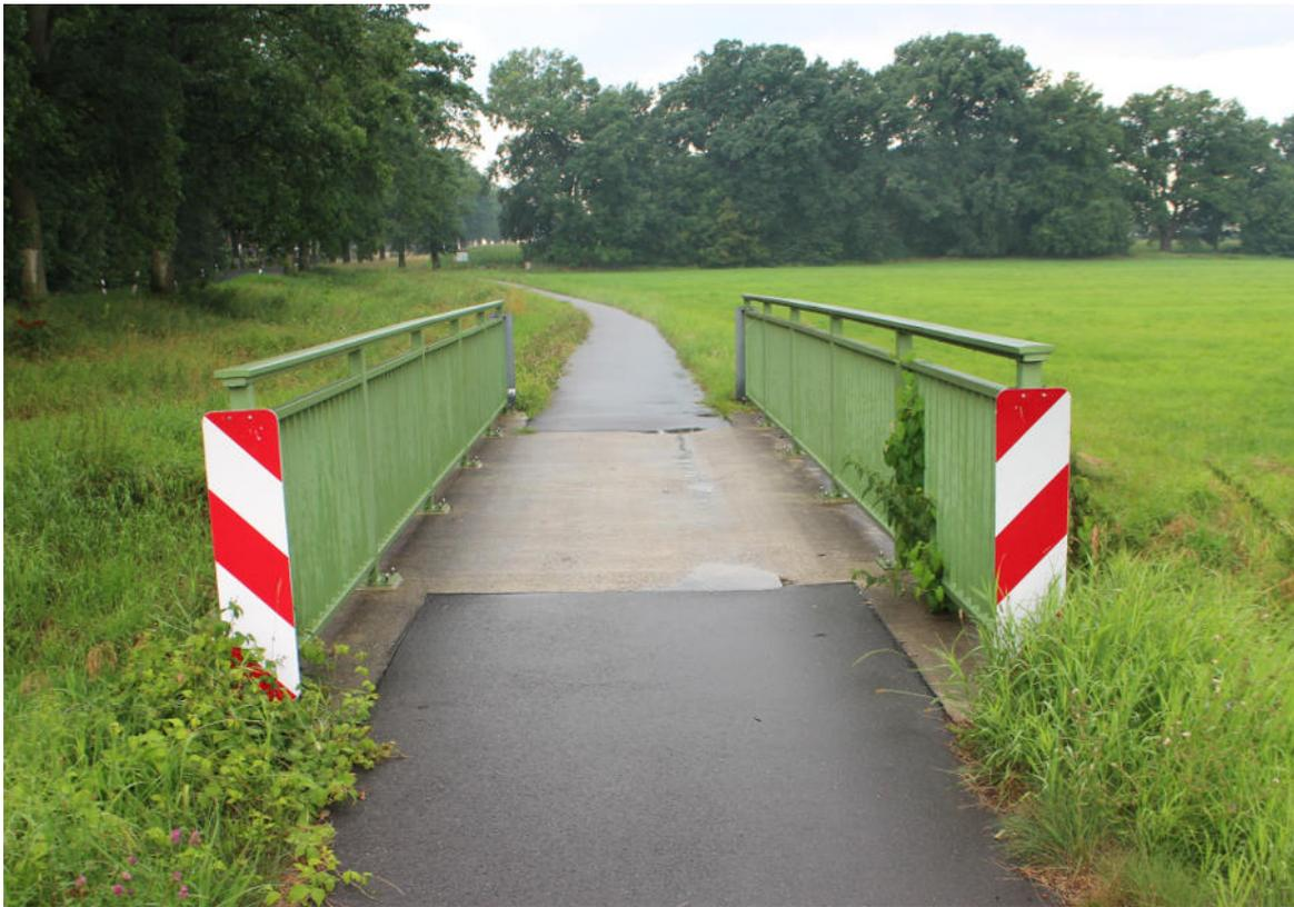
**Abbildung 7.2** Brandenburg: RVA Beeskow – Krügersdorf entlang der B246: Vorbildliche Absicherung der Geländerstöße des grün „getarnten“ Brückengeländers. Bild: Dirk Schmidt 2015.
