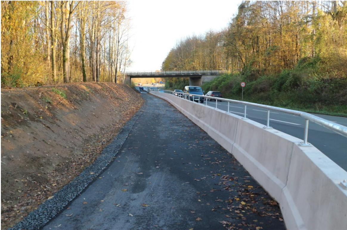
**Abbildung 7.8** Landkreis Kassel zwischen Elgershausen und Altenritte: Radverkehrsanlage mit Trennelement zur KFZ-Fahrbahn. Bild: Dirk Schmidt 11-2018
