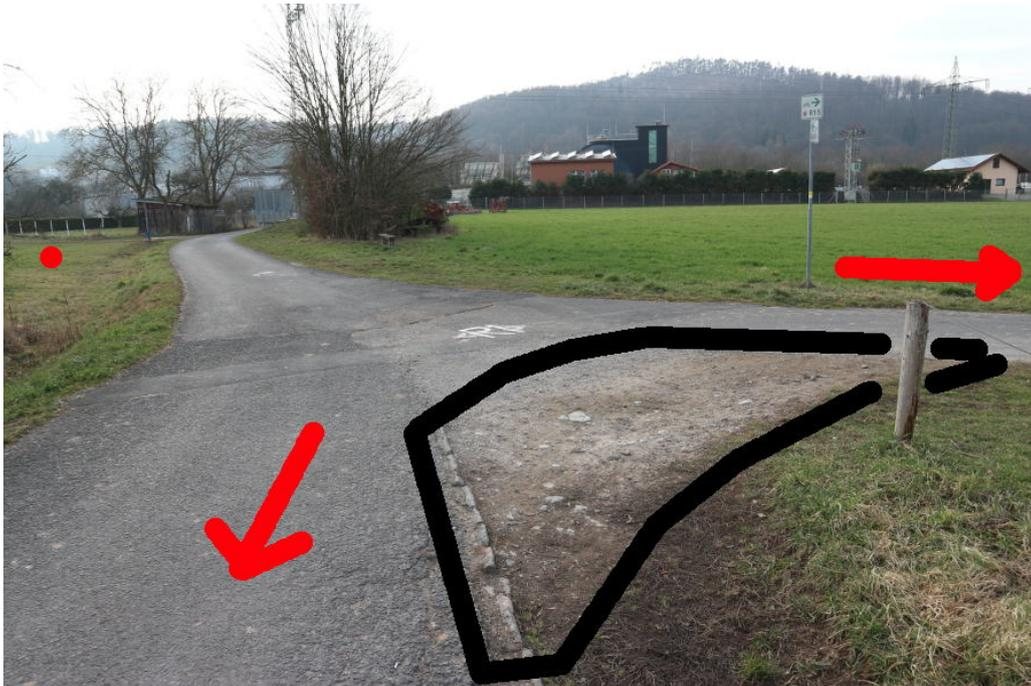
**Abbildung 4.4** Offenes Bankett einer Radwanderroute, was aus Sicherheitsgründen zur Asphaltierung vorgeschlagen wurde (Bild: Dirk Schmidt, 02-2019).
