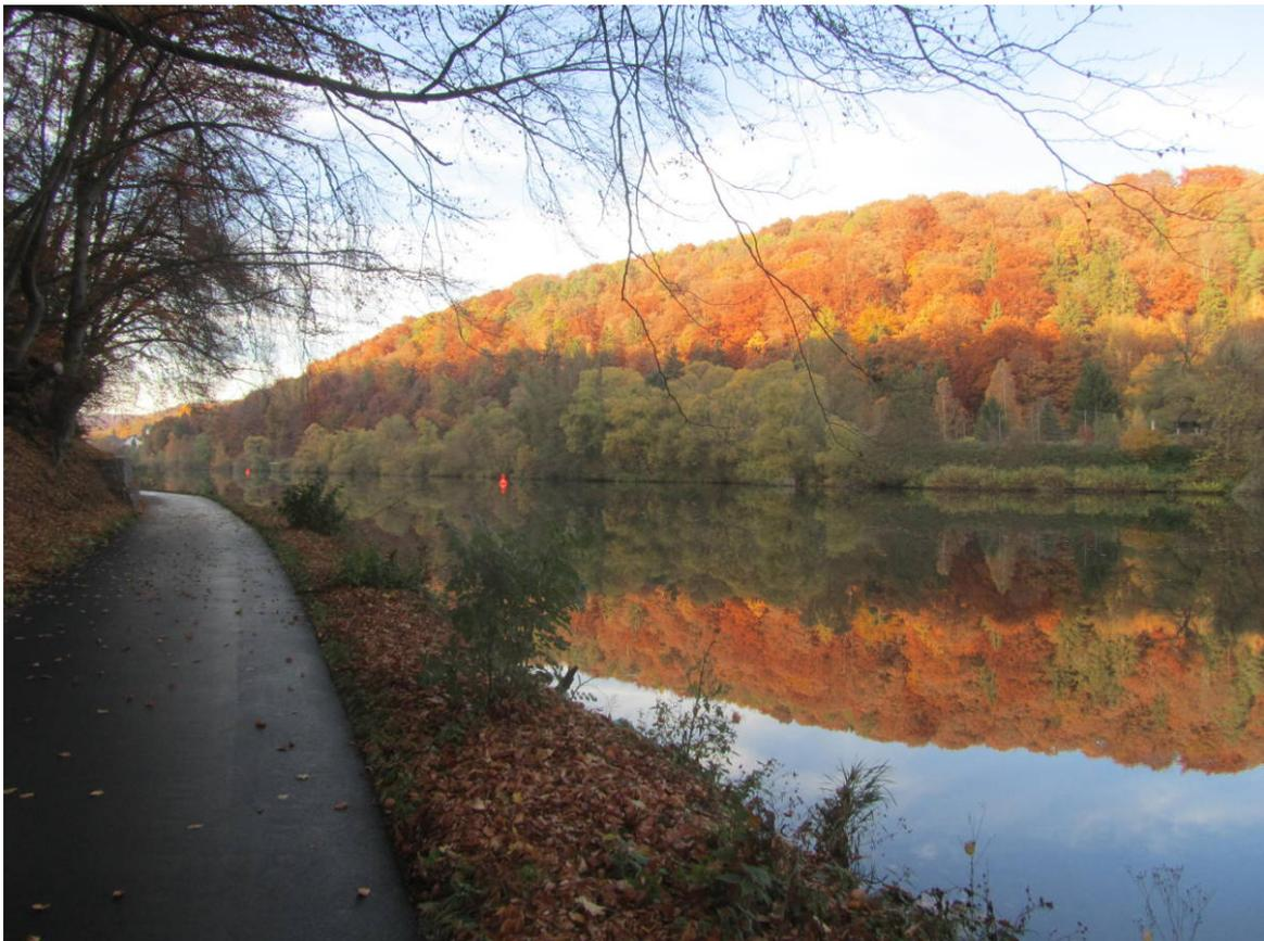
**Abbildung 3.5** Fuldaradweg auf Stadtgebiet Kassel nordöstlich Kassel-Wolfsanger: Im Herbst 2015 wurde diese Strecke auf 3 m Breite in Asphalt ausgebaut. Aber nachts? Obwohl nah am Wasser geführt, wurden keine weißen Fahrbahnbegrenzungslinien aufgebracht, um bei Dunkelheit sicher die Fahrbahn finden zu können. Trotz Fahrradlicht ist dies nicht immer einfach, da der Radscheinwerfer ins „dunkle Leere“ leuchtet. Bild: Dirk Schmidt 10-2015.
