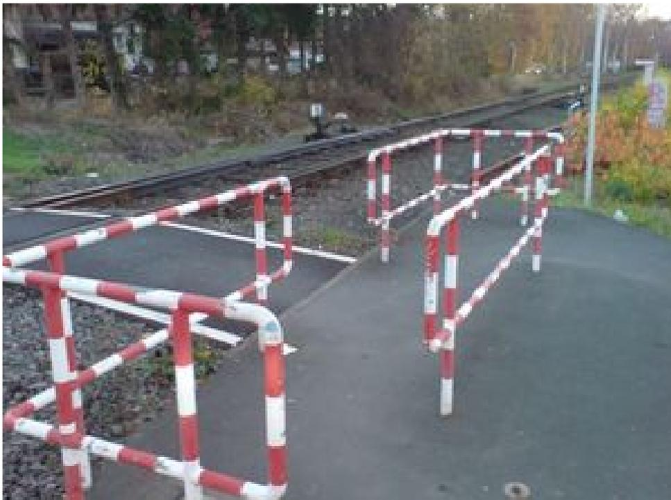
**Abbildung 6.7** Doppel-Umlaufsperr über ein Güterbahngleis bei Kaufungen-Papierfabrik. Versatz als Doppelsperre geringer als in Fürstenwald, aber mit Spezialrädern auch nur schwerer zu passieren. Bild: Dirk Schmidt 11-2018.
