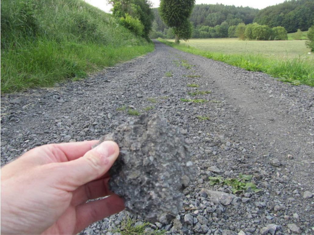
**Abbildung 4.2** Loser, größter „Altasphalt“ aus dem Straßenbau auf einem Wirtschaftsweg. Die Strecke ist lokale heute Teil des Radwegweisungsnetzes (Bild: Dirk Schmidt 04-2014).
