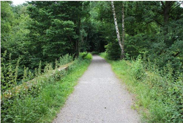
**Abbildung 7.3** Diese Brüstung (grob geschätzt 0,50 m Höhe) am Diemelradweg war 2017 wirklich zu niedrig. Stand 07-2021 wurde das Viadukt umgebaut. (Bild: Dirk Schmidt 09-2017).
