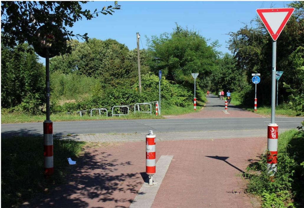
**Abbildung 5.3** Ruhrgebiet Bahnradweg Kry-Wanner-Bahn: An der Querung Kraystraße finden sich statt Pfosten schlanke Rundbarken. Ferner wurden die Standorte richtig gewählt: Ein Mittelpfosten und zwei Randpfosten. So ergeben sich zwei bedarfsgerechte Fahrgassen für den Radverkehr. Bild: Dirk Schmidt 08-2016).
