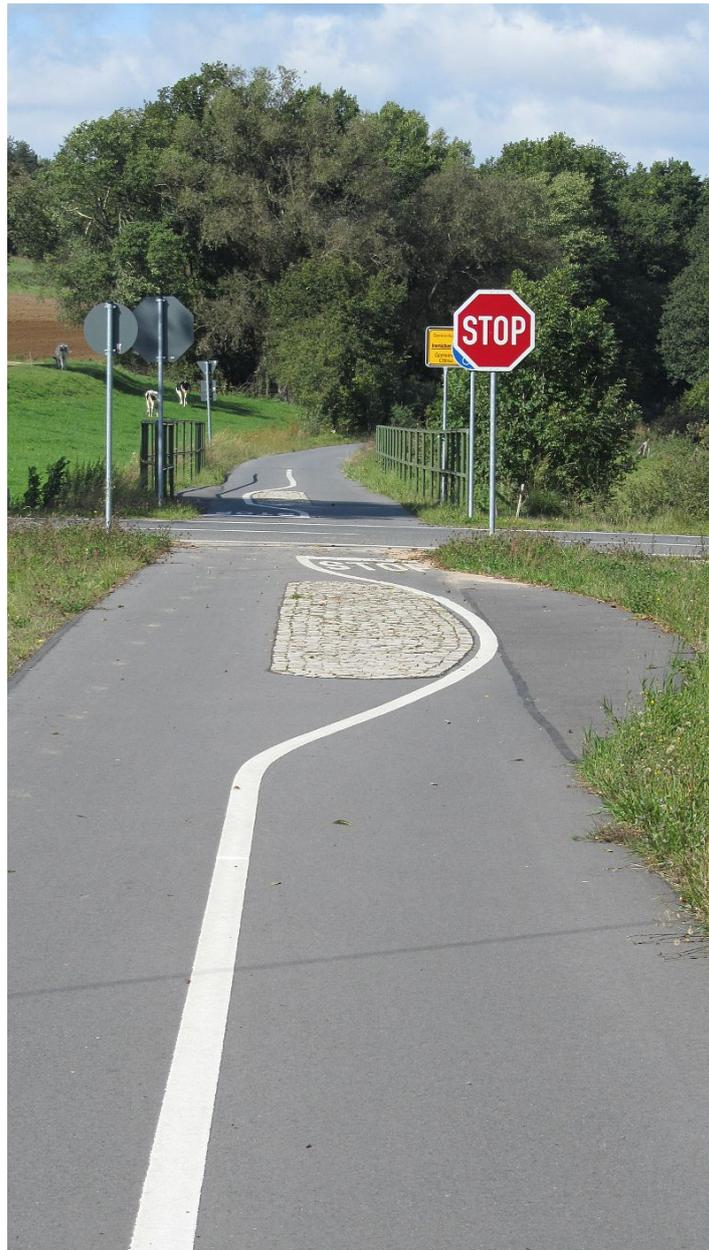
**Abbildung 6.11** Quasi als virtuelle Umlaufsperr dienen die Pflasterinseln am Bahnradweg Rotkäppchenland im Knüll. Bild: Dirk Schmidt 09-2011
