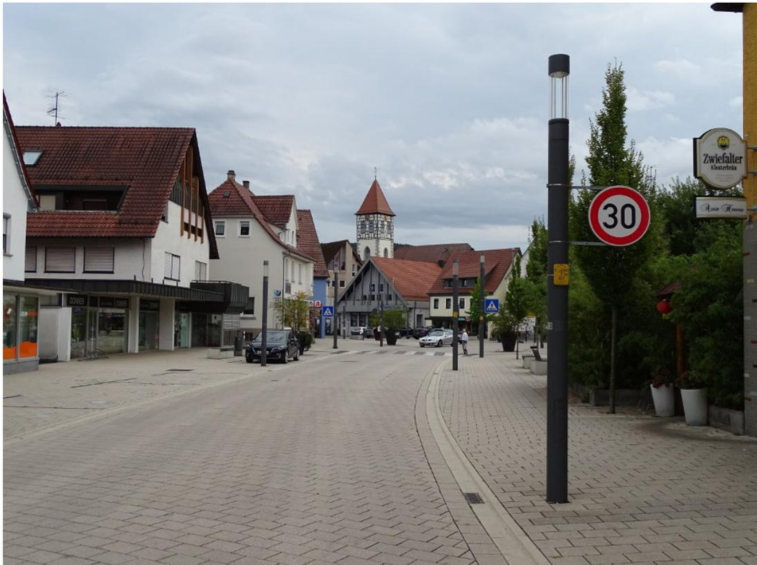
**Abbildung 21.1** Tempo 30 in Rudersberg bei verkehrsberuhigter Gestaltung. Die Leuchten wurden möglichst nah an die Fahrbahn gestellt. Dadurch wirkt die Fahrbahn optisch etwas enger. Dieser Effekt soll zur Geschwindigkeitssenkung beitragen. Bild: Swen Schneider 09-2019
