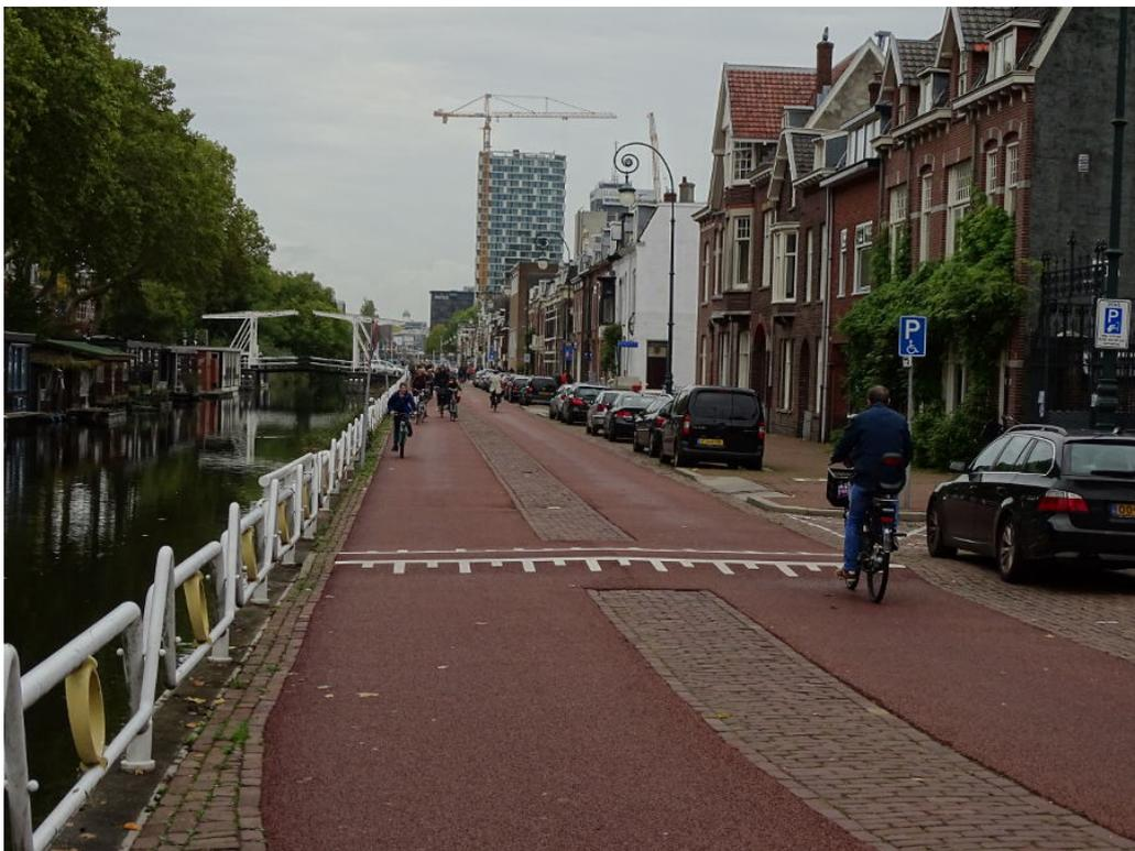
**Abbildung 10.19** Fahrradstraße in Utrecht mit Mittelpflasterung. Bild: Swen Schneider 10-2019
