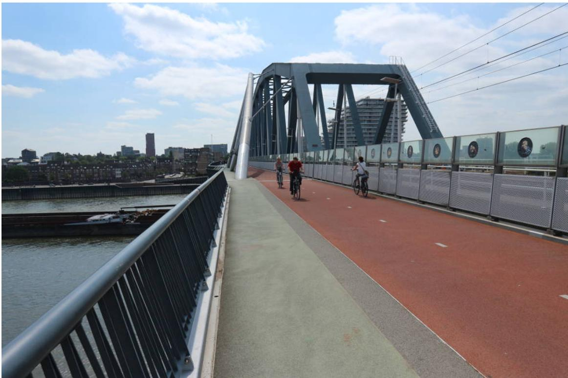
**Abbildung 19.7** Radschnellweg RijnWaalpad zwischen Arnhem und Nijmegen: Das Motiv zeigt die Rheinquerung bei Nijmegen. An die Eisenbahnbrücke wurde hier eine 1900 m (!) lange Fahrradbrücke angedockt. Weitere Infos zur Route: [www.snelfietsroutesgelderland.nl/RijnWaalpad](http://www.snelfietsroutesgelderland.nl/RijnWaalpad). Bild: Dirk Schmidt 07-2018
