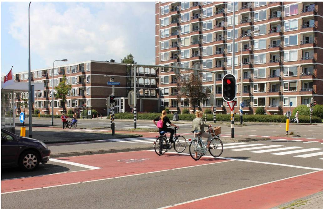
**Abbildung 11.2** nördliche Niederlande: Zwei Radlerinnen nutzen in Groningen selbstbewusst einen ARAS zum direkten Linksabbiegen. Der aufgeweitete Radaufstellstreifen besitzt eine **ergonomische Tiefe von etwa 5 m** und ist somit auch für Gespanne mit Kinderanhänger, Lastenräder mit größerem Lenkradius und Tandems usw. gut nutzbar. Ferner wurde der Streifen in der Signalfarbe rot markiert (Geo 53.19845 6.55809; Bild: Dirk Schmidt 09-2014)
