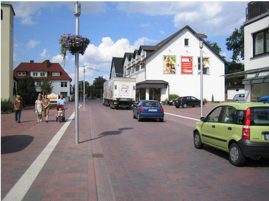
**Abbildung 21.9** Durch die Entwässerung und das taktille Leitsystem besitzt die Verkehrsfläche real durchaus eine Gliederung in "Fahrbahn" und "Fußgängerbereich". Der Bereich zwischen Leitsystem und Entwässerung erscheint so etwas als "Parkstreifen". Bild: Swen Schneider 08-2008.
