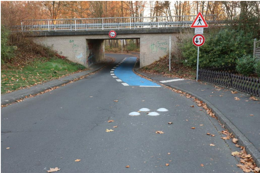
**Abbildung 8.1** Kölner Teller vor einer engen Unterführung (KFZ frei) ohne Gehweg. Hier wären Fahrbahnkissen sicherer. (Bild: Dirk Schmidt 11-2018).
