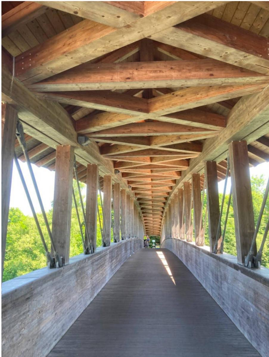
**Abbildung 13.12** Hammerauer Steg: Unterwegs auf dem Bauwerk. Bild: Swen Schneider 08-2023
