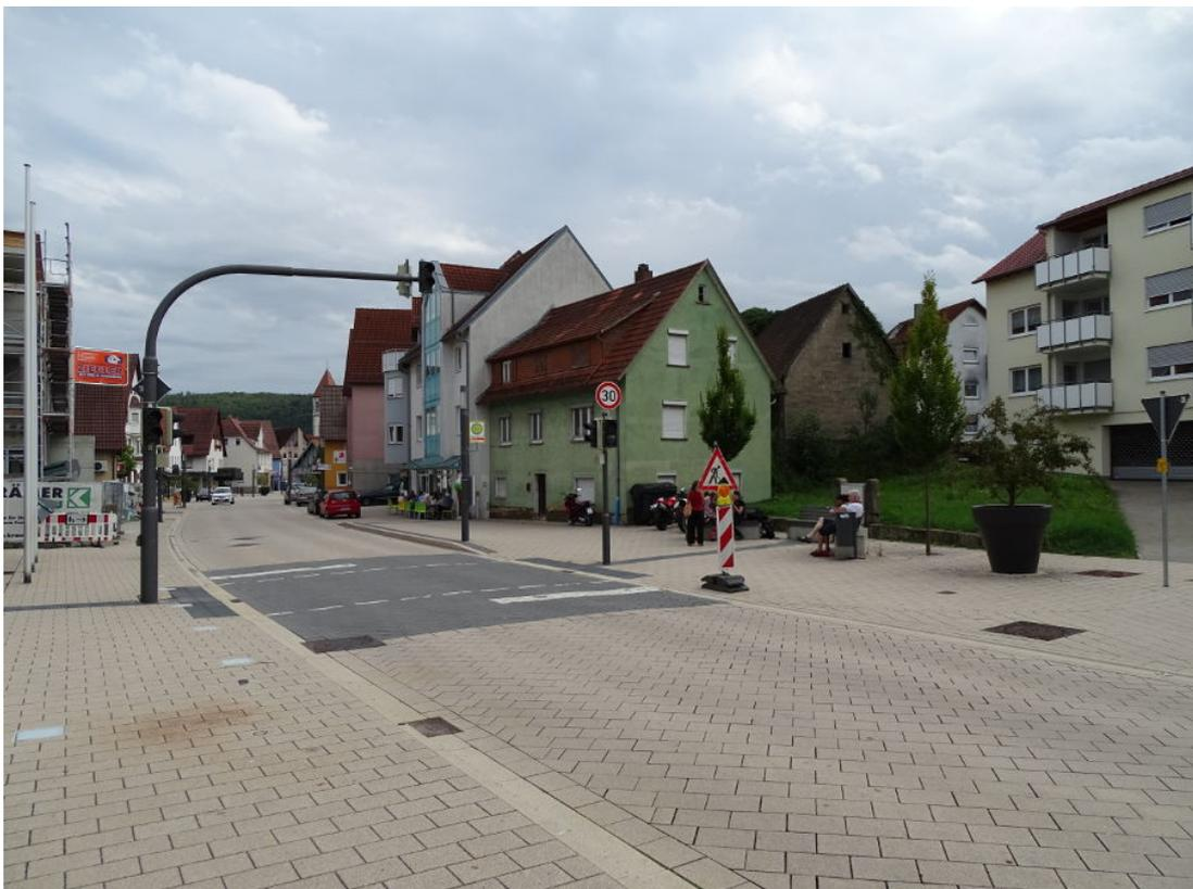
**Abbildung 21.3** Bedarfsampel an einer Bushaltestelle: Die Vorfahrtsstrasse besitzt trotz Tempo 30 auch in der verkehrsberuhigten Gestaltung Querungshilfen für den Fußverkehr. Aufgrund der hohen Verkehrsbelastung ist dies sinnvoll. Bild: Swen Schneider 09-2019
