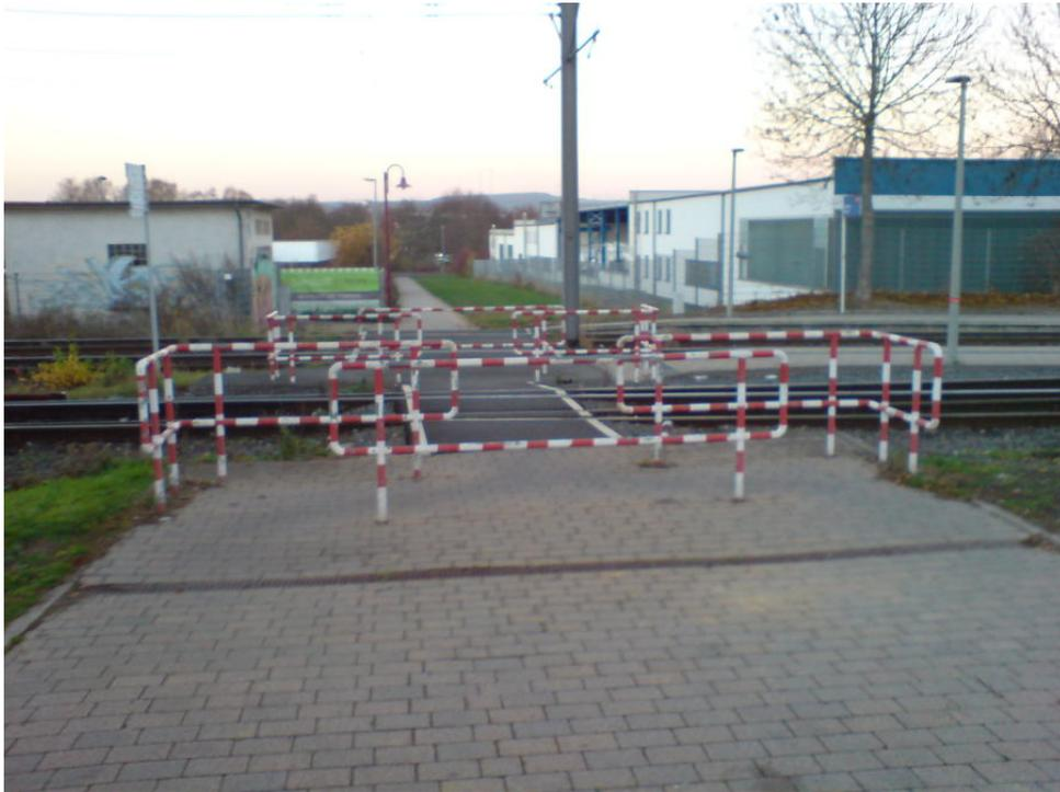
**Abbildung 6.8** Doppel-Umlaufsperr über ein Güterbahngleis bei Kaufungen-Papierfabrik. Versatz als Doppelsperre geringer als in Fürstenwald, aber mit Spezialrädern auch nur schwerer zu passieren. Gegenüber Beispiel Ruhrgebiet größerer Versatz. Bild: Dirk Schmidt 11-2018.
