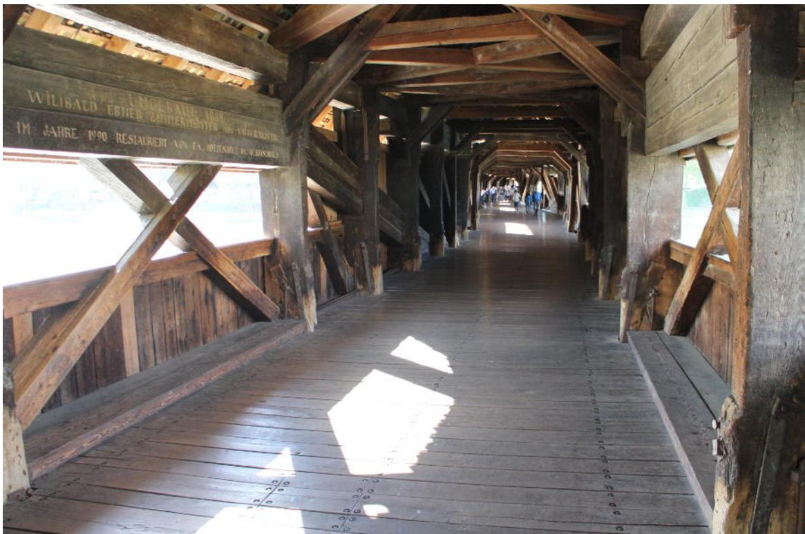
**Abbildung 13.14** Historische Holzbrücke Bad Säckingen: Blick im Bauwerk. Zum Schutz der mächtigen hölzernen Tragekonstruktion ist die Brücke weitgehend mit Holz verkleidet (inklusive Dach). Bild: Dirk Schmidt 10-2016
