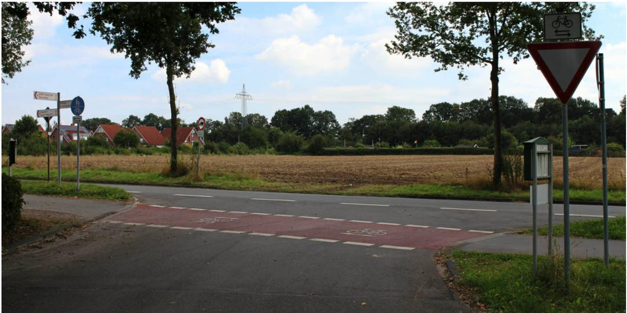
**Abbildung 11.3** vorbildliche Absicherung eines Zweirichtungswegs außerorts nahe Münster: rote Einfärbung der Furt, weiße Fahrradpiktogramme und Doppelpfeile und zusätzlich Schild „Kreuzender Radverkehr von links und rechts“ (Zusatzzeichen 1000-32). Bild: Dirk Schmidt 08-2016)
