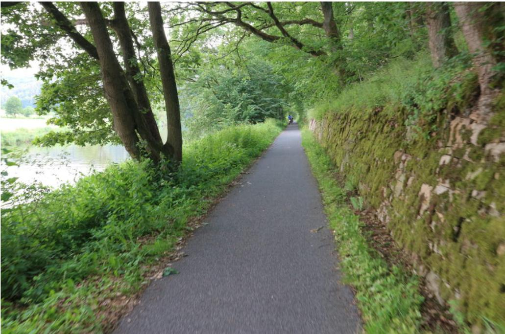
**Abbildung 3.2** gut gepflegte, aber nur 1,7 m bis 1,8 m breite Radverkehrsanlage des Fuldaradweg R 1 zwischen Kassel und Hann Münden. Eine Verbreiterung auf 3 bis 3,5 m wäre wünschenswert (hohes Fahrradaufkommen zu Ausflugszeiten), ist hier aber aufgrund der Topografie faktisch wohl nicht mit vertretbarem Aufwand möglich (Bild: Dirk Schmidt 06-2019.).
