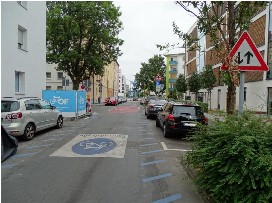
**Abbildung 10.12** Offenbach Fahrradstraße Taunusstraße mit blauer Schrägmarkierung: Auch der wichtige Sicherheitsabstand zu Längsparkern wurde hervorgehoben (Motiv zwei). Bild: Swen Schneider 08-2020
