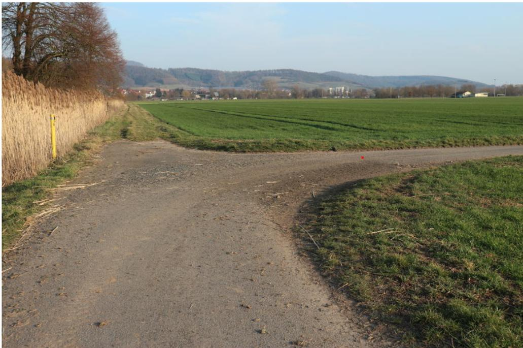
**Abbildung 4.5** Radtouristischer Radfernweg: Schotter im Kurvenbereich, der aus einem ausgefahrenem Bankett stammt. Befestigung des Banketts mit Asphalt wäre sinnvoll (Bild: Dirk Schmidt, 02-2019).
