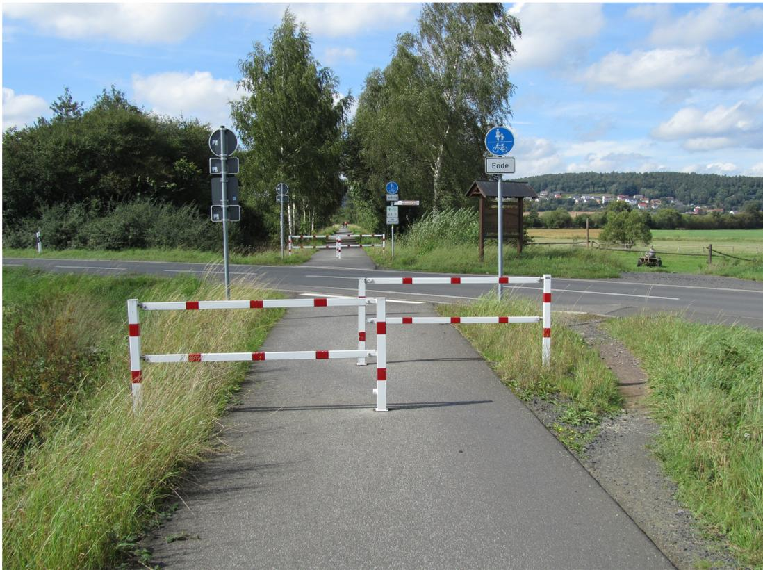
**Abbildung 6.1** Sperre Milseburgradweg Rhön im Jahr 2011. Rechts hatte sich bereits die klassische Umfahrung gebildet. Dies ist auch nicht verwunderlich, denn mit bepacktem Reiserad konnte man selbst beim durchschieben bzw. durchfahren mit Schritttempo noch an den Sperren hängen bleiben. Bild: Dirk Schmidt 2011.
