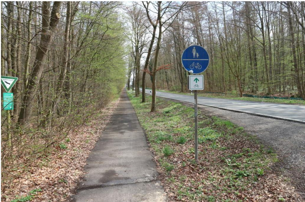
**Abbildung 3.4** Selbe Strecke wie oben: Die ohnehin nicht breite Radverkehrsanlage müsste links einen Grünschnitt erhalten. Verbreiterung auf 2,5 m Mindestbreite nach ERA (besser 3 m) wäre natürlich sinnvoll (Bild: Dirk Schmidt 04-2018).
