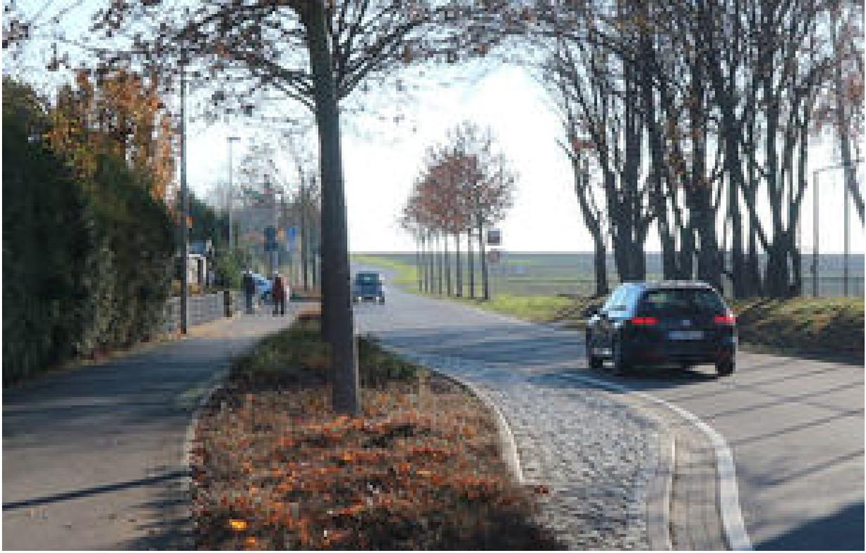
**Abbildung 8.6** Fahrbahnverschwenkung bei Dittershausen-Dennhausen südlich Kassel (Bild: Dirk Schmidt 2018).
