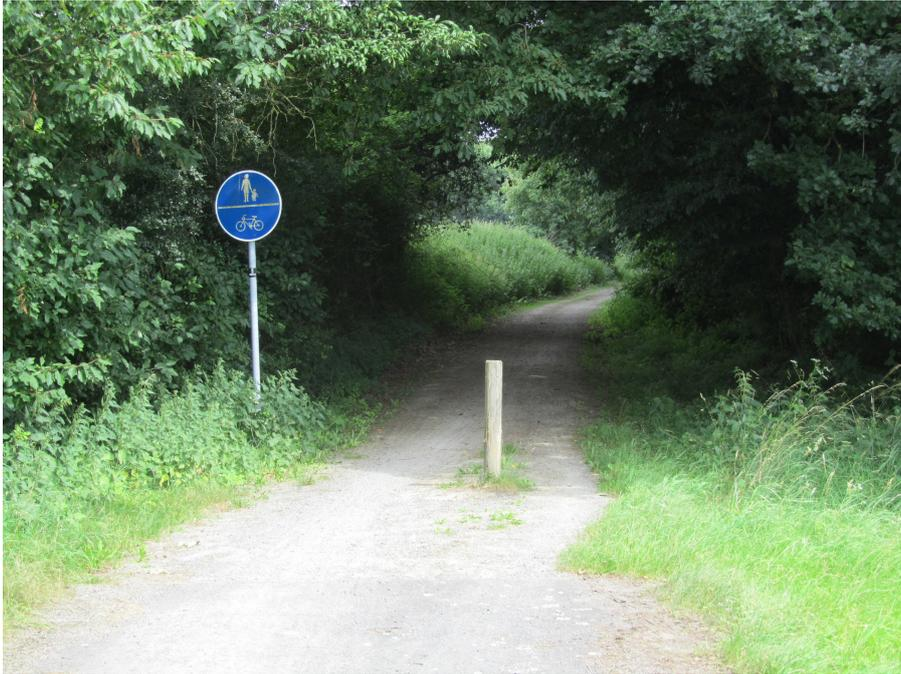
**Abbildung 5.1** Dieser Pfosten außerorts (an einem unbeleuchteten Standort) besitzt keine reflektierenden Elemente. Kollisionsgefahr bei Dunkelheit trotz Fahrradlicht, da der Kontrast fehlt. Allerdings auch tagsüber kann solch ein unscheinbarer, grauer Pfosten übersehen werden (vor allem wenn in Gruppen geradelt wird). Bild: Dirk Schmidt
