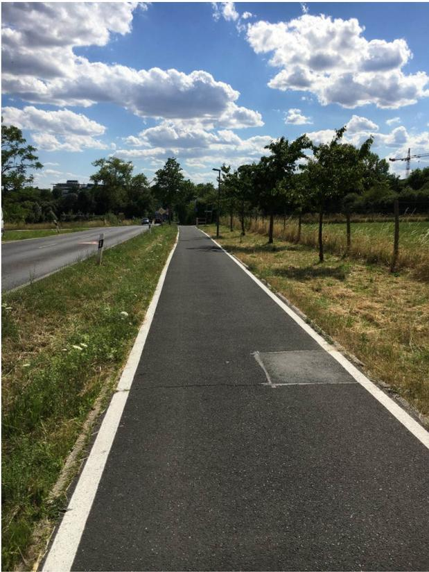
**Abbildung 3.6** Radweg ist aufgrund seiner Fahrbahnrandmarkierungen gut zu erkennen (Bild: Swen Schneider 2020).
