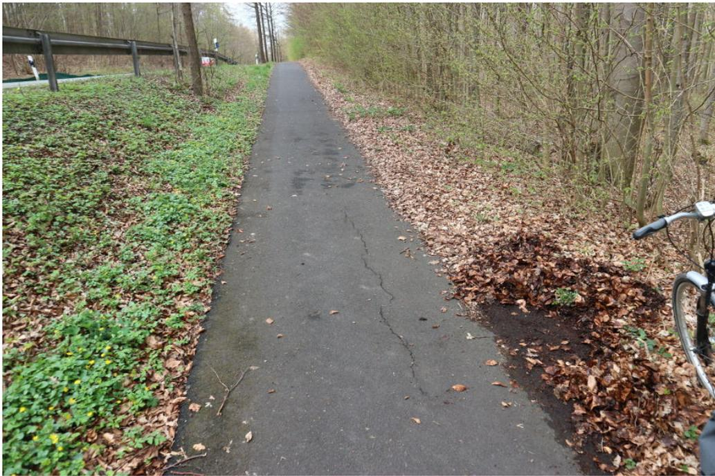
**Abbildung 3.3** „Ausgrabung“ auf einem Radweg in der Region Kassel im Frühjahr 2018. Die ohnehin nicht breite Strecke müsste dringend wieder freigelegt werden und ein Grünschnitt rechts erfolgen (Bild: Dirk Schmidt 04-2018).
