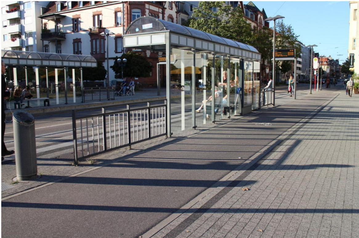
**Abbildung 11.9** Am Wartehäuschen ist die Umfahrung zusätzlich mit einem Geländer abgesichert. Bild: Dirk Schmidt 09-2016)
