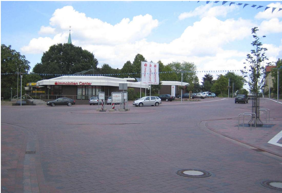
**Abbildung 21.10** Im Bild ein Teil der umgebauten Ortsmitte mit kreisverkehrsartiger Shared Space Fläche. Obwohl die Situation wie eine Art „Kreisverkehr“ wirkt, gilt hier die allgemeine Verkehrsregel „Rechts vor Links“ bei Tempo 50 (da entsprechende Verkehrsschilder fehlen). Motiv bei Geo 52.36793 8.31354; Bild: Swen Schneider 08-2008.
