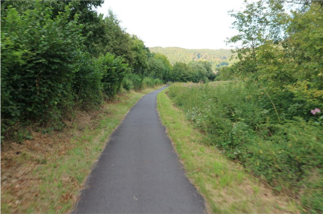
**Abbildung 3.1** zwar gut gepflegte, aber schmalere Strecke mit real 1,7 bis 1,8 m Breite im Raum Melsungen mit auch hoher Alltagsbedeutung parallel der B 83. Hier wäre mittelfristig eine Verbreiterung auf 3 m bis 3,25 m sinnvoll (Bild: Dirk Schmidt 06-2019.)
