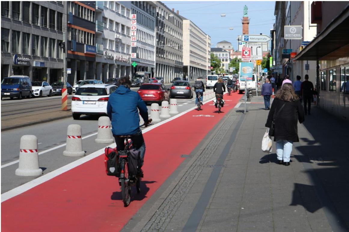
**Abbildung 5.7** Blick stadteinwärts: Links der neue, geschützte Radfahrstreifen. Rechts zwischen den schwarzen „Linien“ verlief früher der Radweg auf dem Bürgersteig (in dem Bereich, in dem nun die Frau mit dem dunklen Mantel läuft). Bild: Dirk Schmidt 05-2019.
