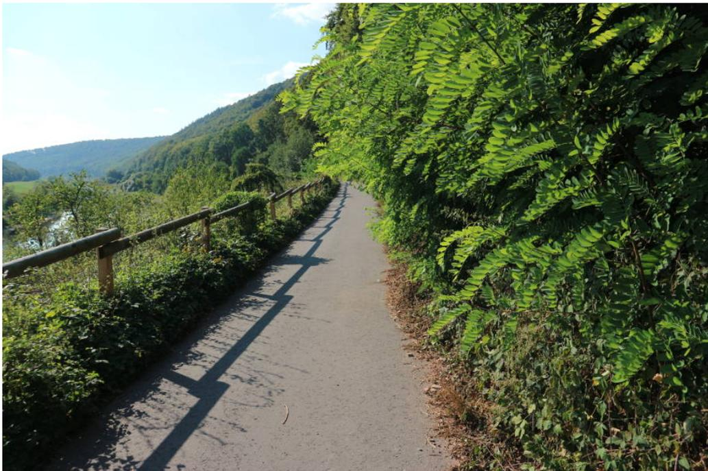
**Abbildung 9.3** Radtouristischer Radfernweg außerorts im Spätsommer: In Gesichtshöhe fasst mitten im Weg fanden sich diese dornigen Akazientriebe. Die Strecke liegt in Hanglage und die Triebe wachsen vom Hang rechts in das Lichtraumprofil. Hier muss offenbar zwei Jahre, eher allerdings drei Jahre, kein Grünschnitt mehr erfolgt sein (Bild: Dirk Schmidt, 09-2018).
