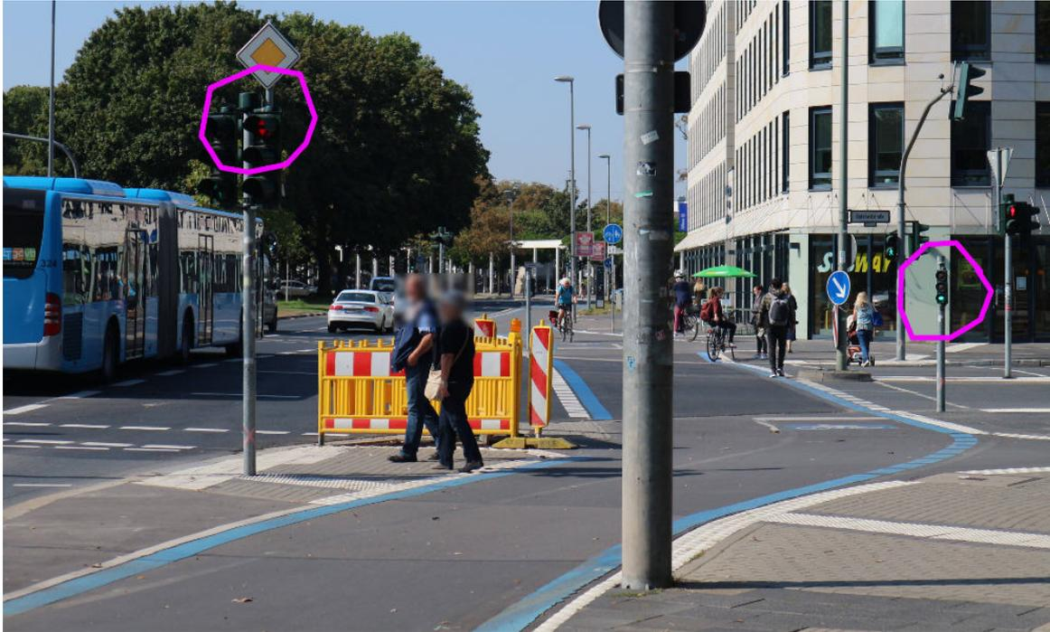
**Abbildung 11.1** Am Radschnellweg Göttingen findet man am Knoten „Berliner Straße / Godehardstraße“ eine separate Ampelphase für den geradeaus fahrenden Radverkehr. Geo 51.53738 9.93063. Von dem Umbau gab es an dieser Stelle übrigens nach Luftbildern im Netz einen baulichen Rechtsabbieger für den Kfz-Verkehr mit Zebrastreifen. Mit der Integration des Radschnellwegs wurde auch dieser Gefahrenpunkt beseitigt. Bild: Dirk Schmidt 06-2015
