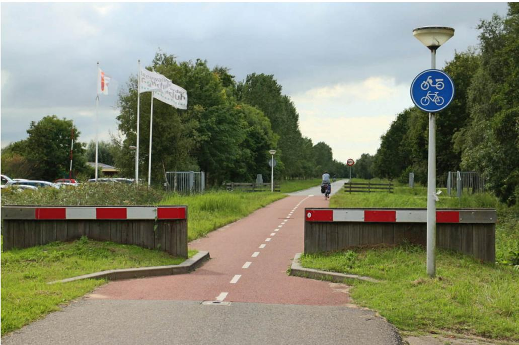
**Abbildung 5.6** Gesehen in den nördlichen Niederlanden östlich Leeuwarden: Einengung statt Pfosten für die Verhinderung von Kfz-Schleichverkehr. Diese Lösung ist allerdings eher nur bei wenig Radverkehr anwendbar, da sich de facto eine einspurige Engstelle ergibt. **In der Regel sollten besser gut abgesicherte Pfostenperren mit drei Pollern zum Einsatz kommen.** (Bild: Dirk Schmidt 06-2014 bei Geo 53.21032 5.89162).
