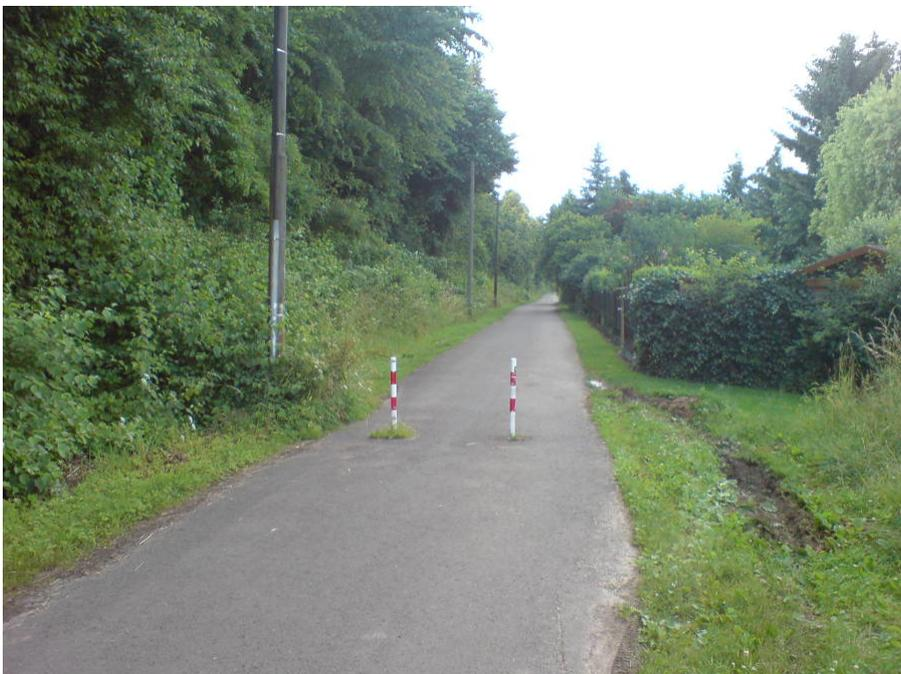
**Abbildung 5.2** unergonomische Pfostensperre gegen KFZ-Verkehr auf einer unbeleuchteten, urbanen Nahmobilitätsroute. Die beiden Pfosten stehen direkt in den Fahrspuren. So kann rechts sogar noch KFZ-Verkehr durch fahren (Bild: Dirk Schmidt).
