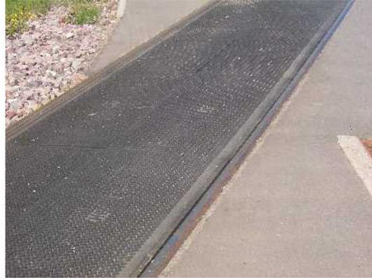
**Abbildung 4.10** Werksbahnanschluss mit Gummiplatten (Bild: Dirk Schmidt; gesehen im Kraichgau Baden-Württemberg um das Jahr 2003)
