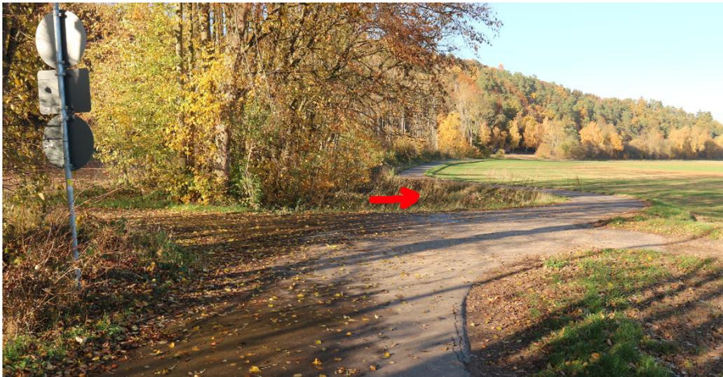
**Abbildung 3.9** Bild 1: Gute ausgebaute Strecke, aber ungesicherte Kurve um einen Graben auf unbeleuchteter Strecke außerorts. Die Verschwenkung um den Graben ist bei Dunkelheit trotz Fahrradlicht evtl. schwer zu erkennen (da Kontrast fehlt). Hier sollten im Kurvenbereich unbedingt weiße Fahrbahnbegrenzungslinien aufgebracht werden. Ferner wären zwei rot-weiße Reflektorbaken sinnvoll.
