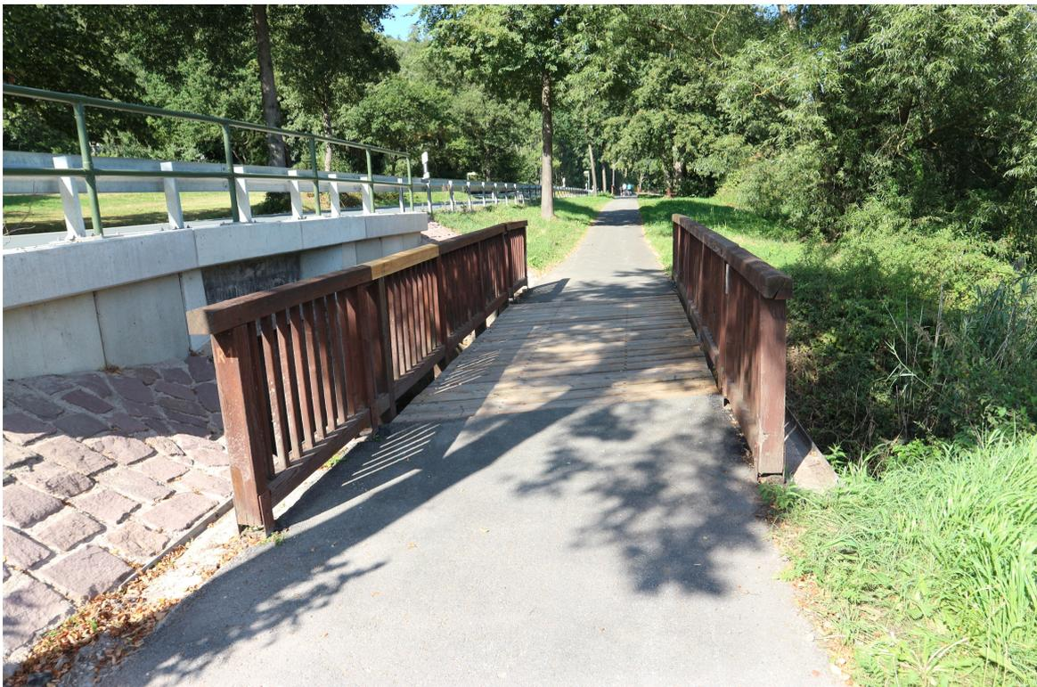
**Abbildung 7.1** gefährliche Geländerstöße eines braun „getarnten“ Brückengeländers direkt am Fahrbahnrand (außerorts auf unbeleuchteter Strecke). Bild: Dirk Schmidt 2019.
