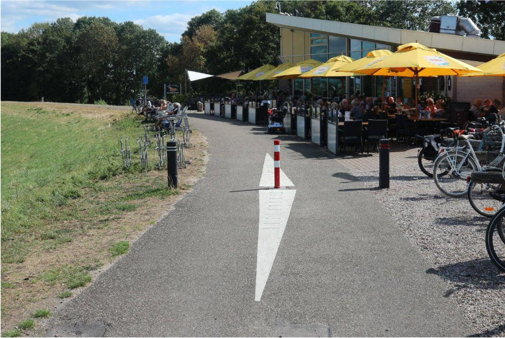
**Abbildung 5.5** Niederlande: vorbildliche Absicherung eines mittleren Sperrpfostens mit weißer Keilmarkierung. In die Keilmarkierung sind zusätzlich Rüttelstreifen eingearbeitet. Die beiden äußeren Sperrpfosten sind schwarz mit Reflektoren. Optimaler wären hier natürlich auch rot-weiße Poller gewesen (Bild: Dirk Schmidt 08-2018 bei Geo 51.86532 6.05452).
