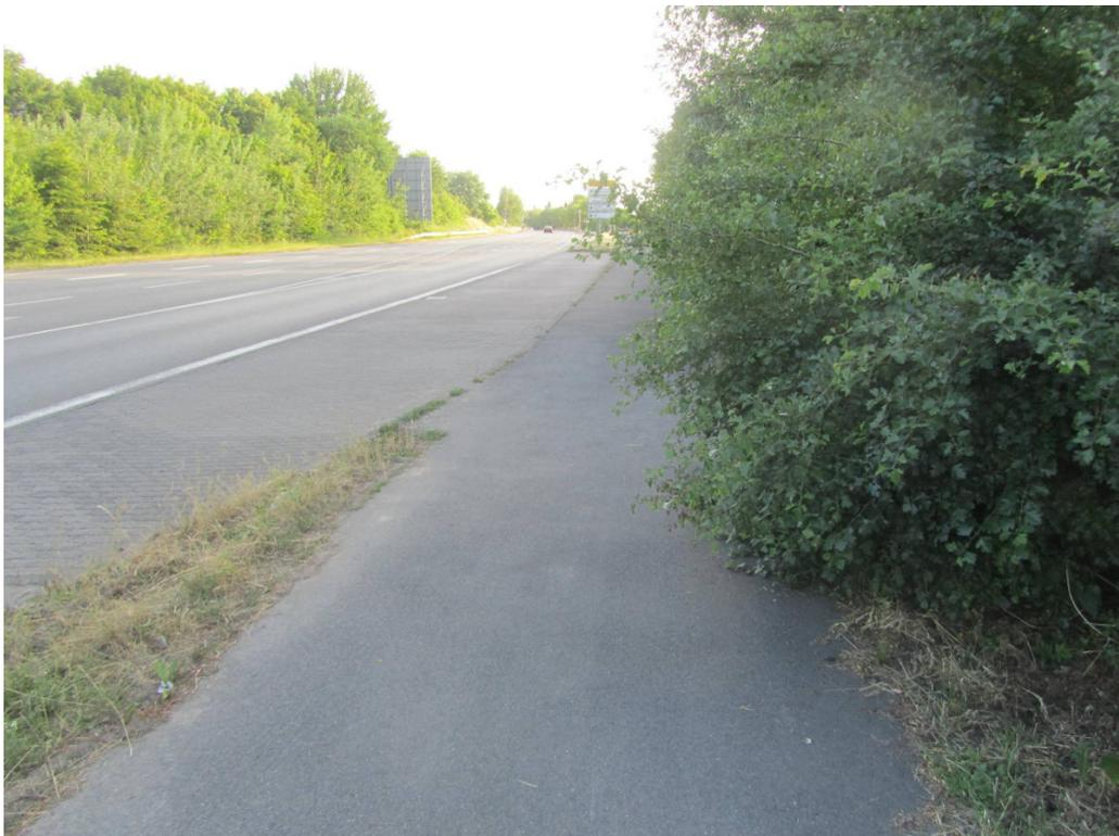
**Abbildung 9.1** An dieser Radverkehrsanlage entlang einer Straße wurde wohl schon deutlich länger als ein Jahr kein Gehölzschnitt vorgenommen. Die Strecke ist bereits halb zugewachsen. Bild: Dirk Schmidt 06-2015
