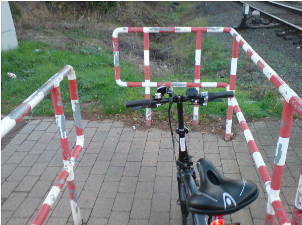
**Abbildung 6.9** Doppel-Umlaufsperr über ein Güterbahngleis bei Kaufungen-Papierfabrik. Die Breite dürfte geschätzt 1,30 m betragen. Der Fahrradlenker ist rund 0,65 m breit. Mit dem Normalrad lässt sich die Sperre problemlos durchschieben. Versatz als Doppelsperre geringer als in Fürstenwald, aber mit Spezialrädern auch nur schwerer zu passieren. Bild: Dirk Schmidt 11-2018
