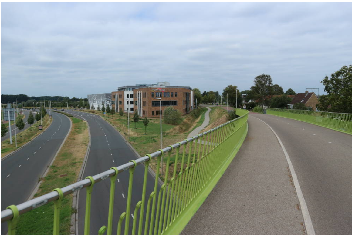
Abbildung 10.2 Bildunterschrift: die Fahrrad- und Fußgängerbrücke über die Westumgehung von Nijmegen bei Geo 51.86400 5.85841 war nur ein kleiner Vorgeschmack auf vielleicht Europas längste Fahrradbrücke.
