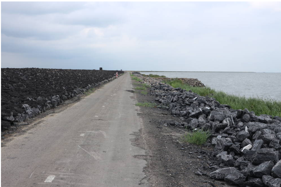
Abbildung 7.10 Bildunterschrift: Blick Richtung Enkhuizen: Hier sind die Steine links bereits eingebaut. Die Steinschicht wurde mit einer Teerlage gesichert
