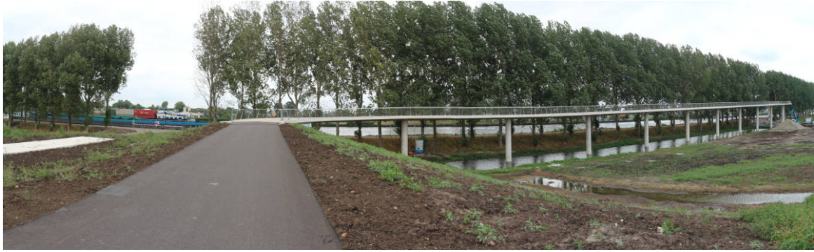
Abbildung 9.10 Bildunterschrift: Für die Rampen wurden statt langer Erdwälle zu großen Teilen offene Brückenrahmen errichtet, die mit einer einreihigen Pfeilerkonstruktion auskommen: Die Westrampe wurde weitgehend parallel der Baumallee am Kanal errichtet.
