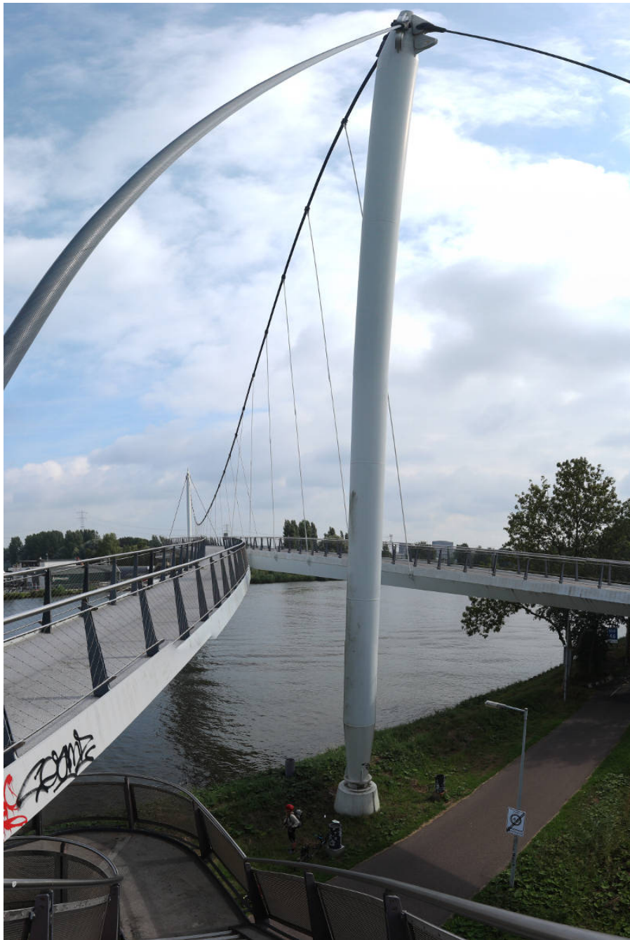
Abbildung 9.3 Bildunterschrift: Blick vom Treppenturm auf das Bauwerk (Panorama; deshalb etwa schief). Hängenbrücken sind in den Niederlanden eher selten, da die Verankerung des Hauptkabels im weichen Boden technisch sehr anspruchsvoll ist. Das Problem wurde bei der Nesciobrug gelöst, in dem Lasten geteilt wurden und die verankert wiederum Teil des Bauwerks sind.
