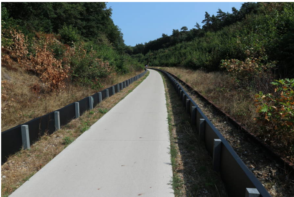
Abbildung 10.8 Bildunterschrift: Amphibienschutzanlage am Bahnradweg nach Groesbeek (grob bei Geo 51.7750 5.9059)
