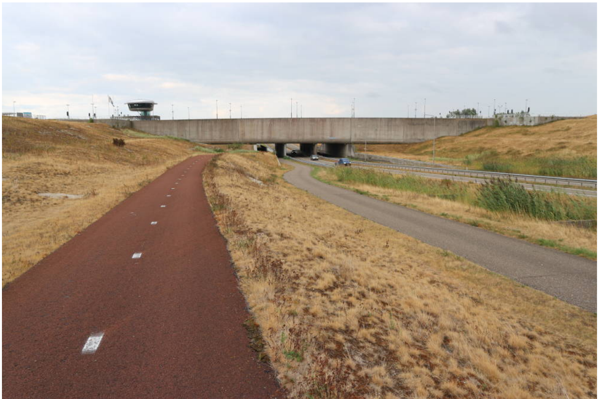
Abbildung 7.15 Bildunterschrift: Neue Schleusen mit Unterführung.
