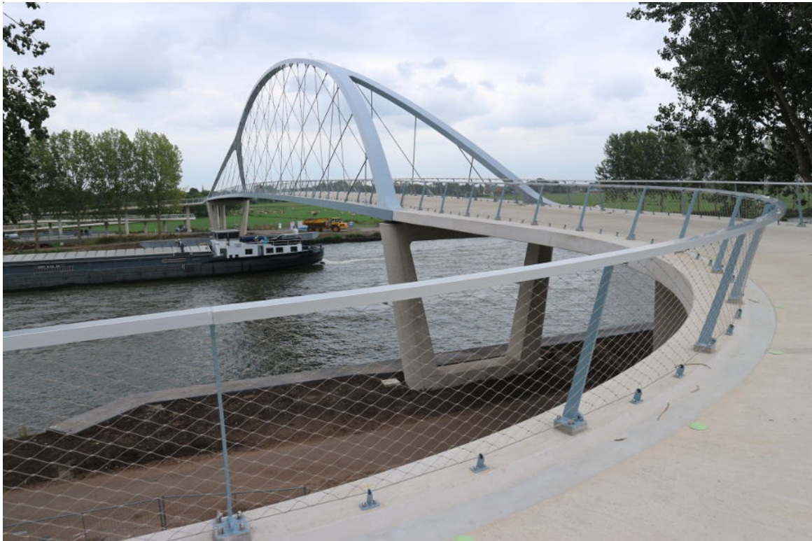
Abbildung 9.7 Bildunterschrift: Blick auf die Bogenbrücke
