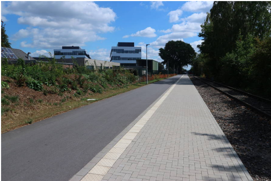
Abbildung 10.13 Bildunterschrift: Kleve: Blick von der flutstraße in den bereits fertig gestellten Abschnitt der Europa-Radbahn Richtung Bahnhof Kleve. Es wurde hier innerorts aufgrund des erhöhten Fußgängeraufkommens eine bauliche Trennung zwischen Rad- und Fußverkehr eingerichtet.
