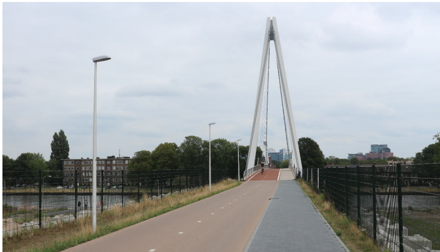
Abbildung 9.13 Bildunterschrift: Die westliche Zufahrt zur Brücke ist weitgehend eben, da die Radroute hier von der Höhe der Autobahneinhausung kommt. Hier wurde mit großem Aufwand die Autobahn in einen achtspurigen Lärmschutztunnel gelegt. Das Gelände wird noch als Park gestaltet. Im August 2018 sah es hier noch etwas nach Baustelle aus.
