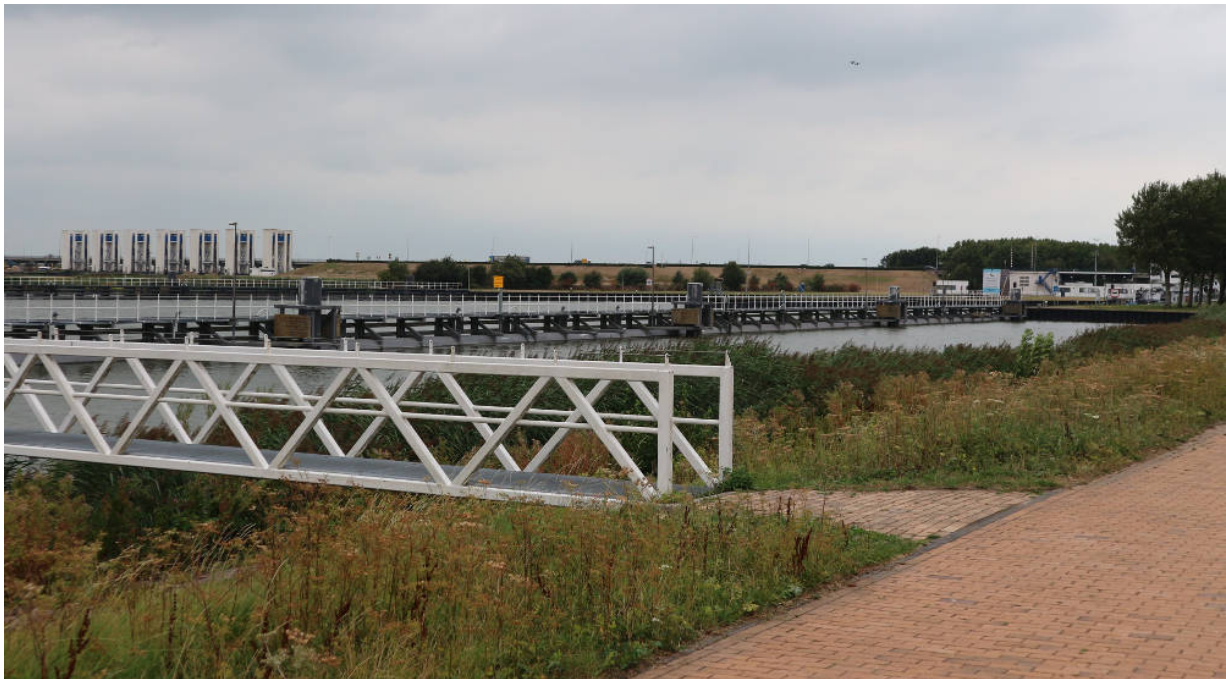
Abbildung 7.8 Bildunterschrift: Beginn des Markerwaarddijk von der Promenade in Lelystad gesehen. Links die Wehre zur Wasserregulierung, rechts die Schleusen mit Klappbrücken für die Schifffahrt.
