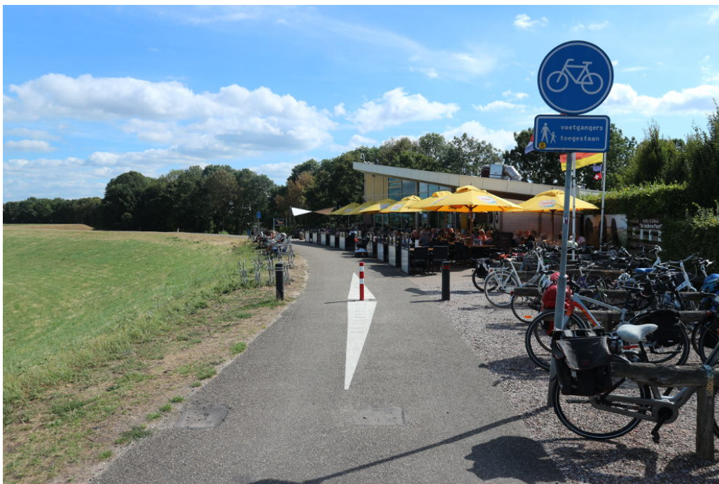
Abbildung 5.5 Bildunterschrift: Bereits in den Niederlanden: Oberhalb des Fähranlegers Millingen findet sich Gastronomie. Man beachte die Pollersperre: ein Pfosten mit langer, weißer Warnmarkierung in der Mitte und zwei weitere Pfosten links und rechts. So macht man das richtig! In Deutschland dagegen stehen oft zwei Poller direkt in den Fahrspuren.
