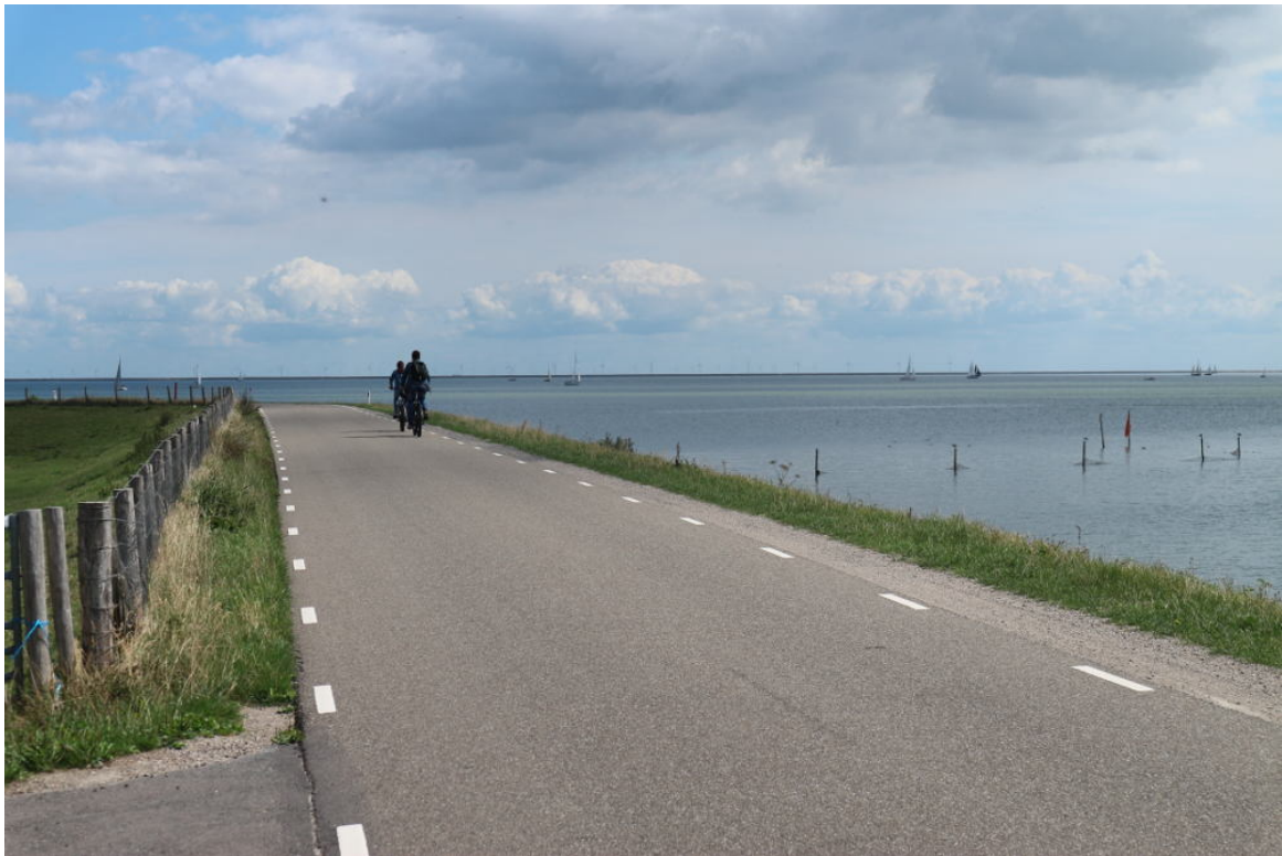
Abbildung 8.2 Bildunterschrift: Deichstraße mit Markermeer. Der Wasserspiegel dürfte hier geschätzt etwa 2,5 bis 3 m höher liegen als der Polder hinter dem Deich.
