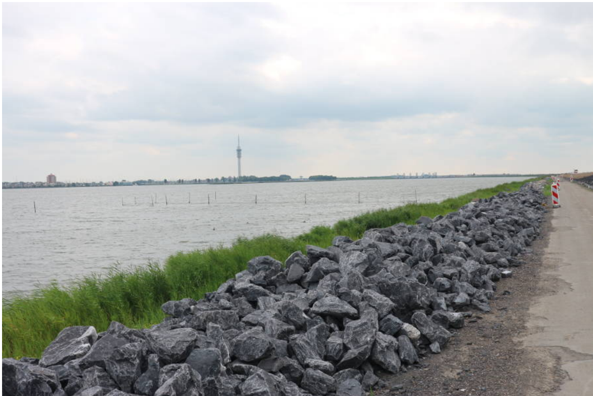
Abbildung 7.9 Bildunterschrift: Blick zurück auf Lelystad. Am Radweg lagern bereits Steine für die Dammsanierung.
