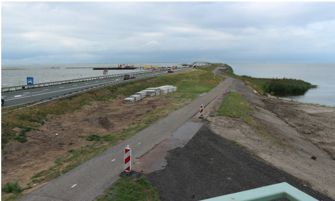
Abbildung 7.12 Bildunterschrift: auf dem Container Höhe Trintelhaven, Blick Richtung Enkhuizen: Schautafeln informieren hier über die Dammsanierung: Während aufgrund des tieferen Meeresbodens zwischen Lelystadt und Trintelhaven der Damm mit neuen Steinlagen gesichert wird, kommt zwischen Trintelhaven und Enkhuizen ein anderes Verfahren zum Einsatz: hier soll der Damm beiderseits durch neue, 70 m breite Sandaufspülungen zusätzlich gegen Sturm gesichert werden. Zusätzlich werden im Markermeer nahe des Damms durch Sandaufspülungen auch neue Inseln für die Tier- und Pflanzenwelt geschaffen
